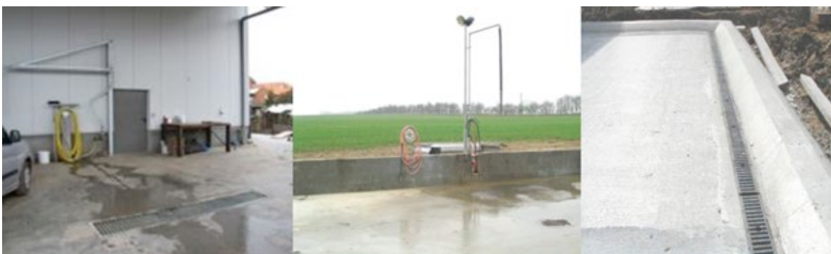
Afbeelding 42. Vul- en wasplaats: galgsysteem voor het vullen van een spuittoestel (bron: Inagro)
