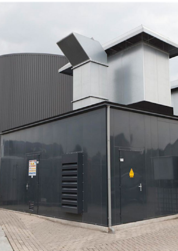
Warmtekrachtkoppeling-installatie
