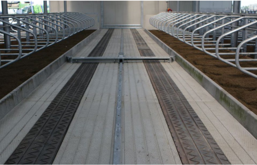
Figuur 34: Loopgang voorzien van loopstroken in rubber en mestschuif
