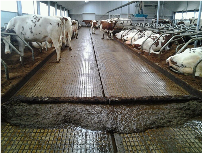
Figuur 22: V-vormige vloer met gierafvoerbuis en mestschuif (bron: HCI-beton)
