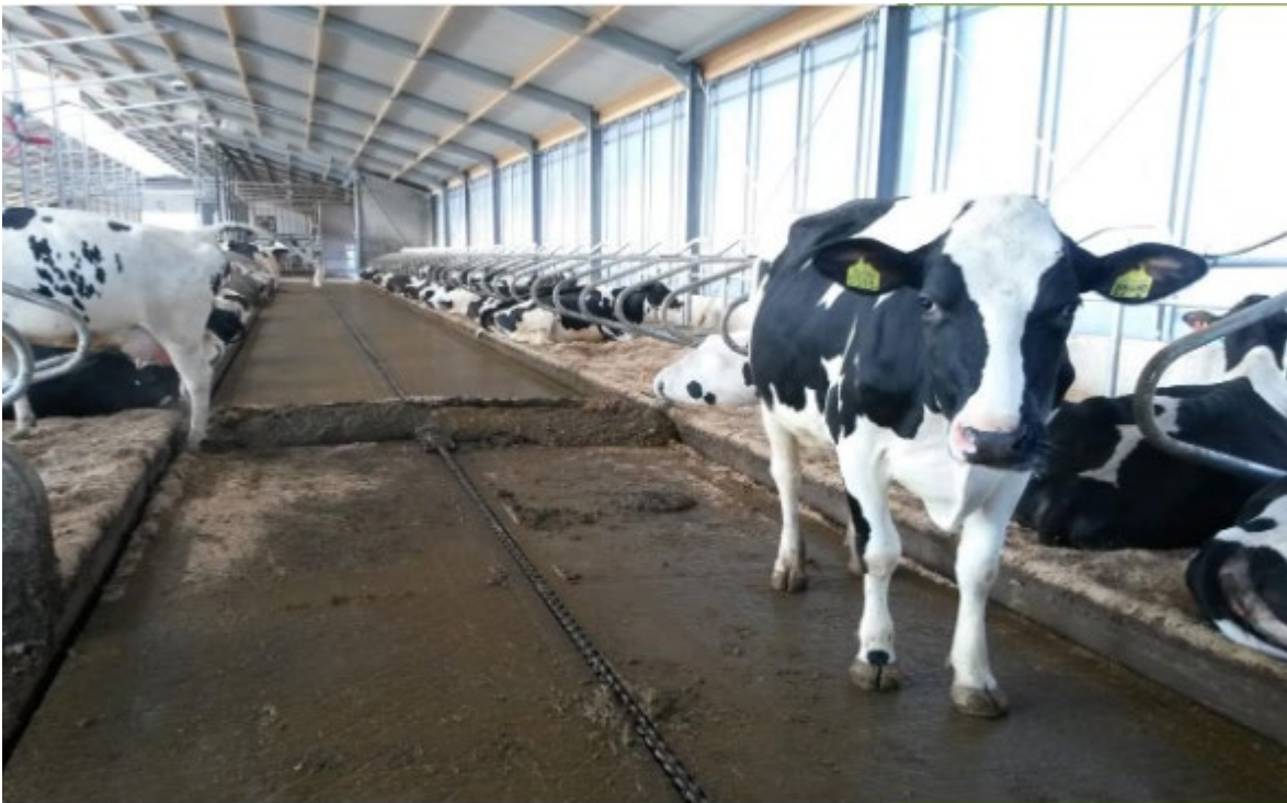
Figuur 27: Hellende vloer met twee giergoten aan de zijkant en mestschuif (bron: Berkelbeton)
