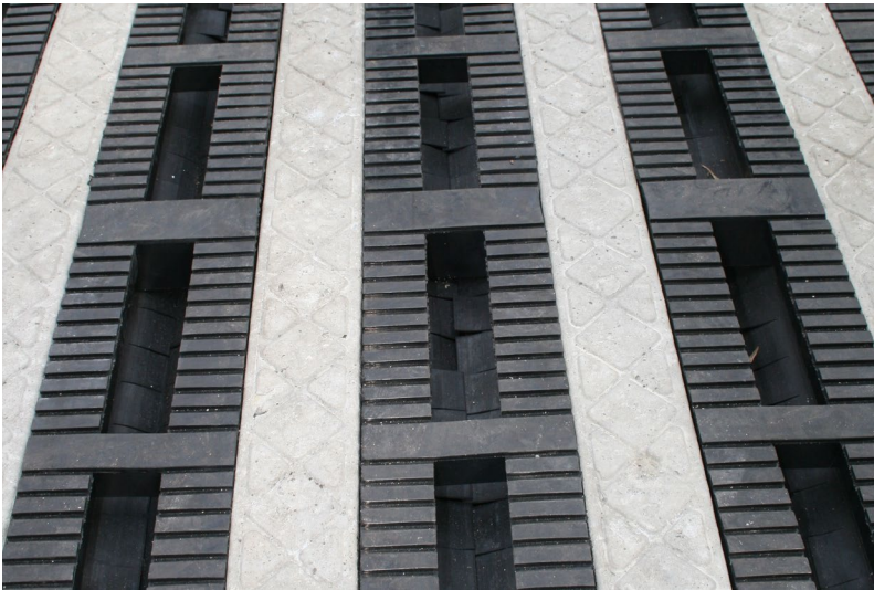
Figuur 13: Roostervloer met rubberen inlegcassettes en afsluitkleppen
