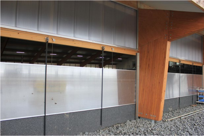
Figuur 36: Stal voorzien van automatisch gestuurde winddichte gordijnen
