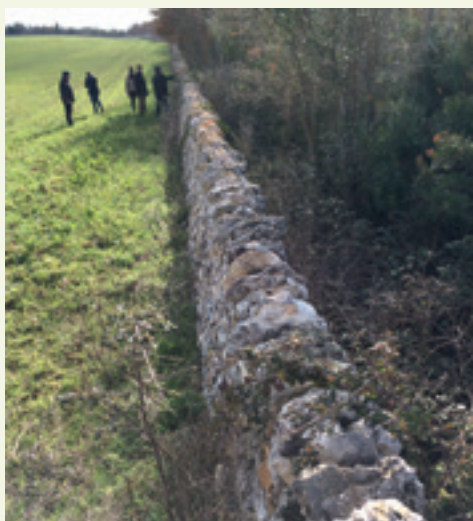
Mur de pierres sèches dans les Pouilles (IT) Source: Cour des comptes européenne.
